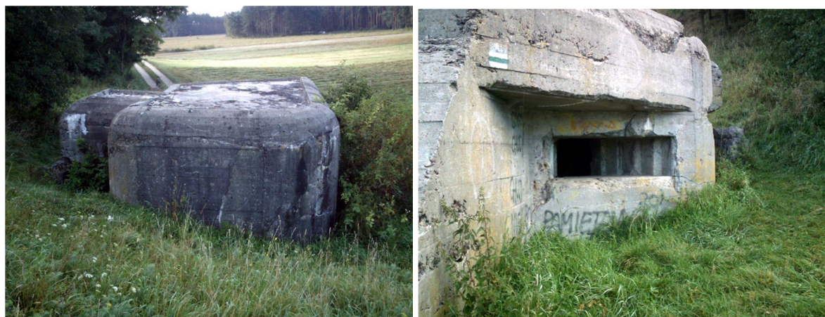
Rysunek 18. Bunkry na linii obrony Stońsko-Beleń
