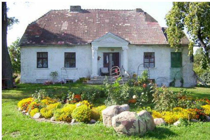
Dwór w Dziadkowicach -widok od strony wschodniej (źródło: Gminna Ewidencja Zabytków)
