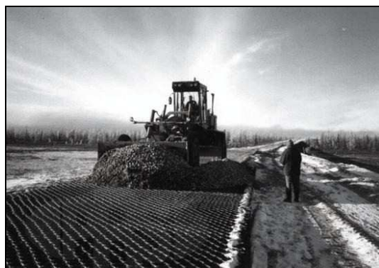
Rys. 8. Zasypywanie kruszywem komórek geosiatki za pomocą ładowarki
