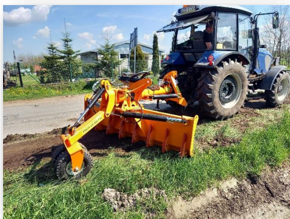
Fot. 45. i 46. Ścinarka poboczy i odkurzacz spalinowy
