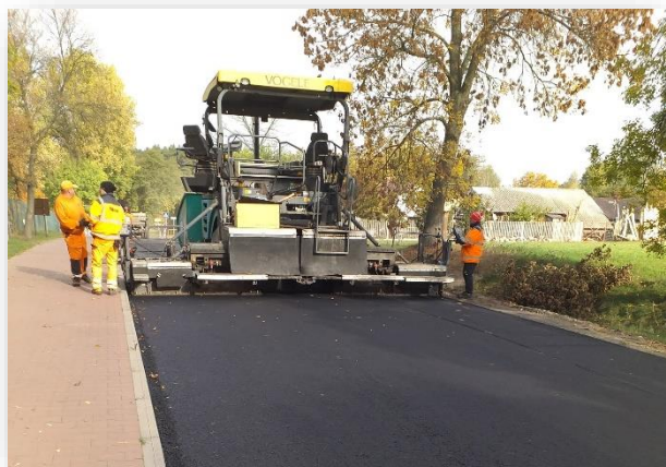
Fot. 7. i 8. Prace przy przebudowie drogi powiatowej nr 4908E
