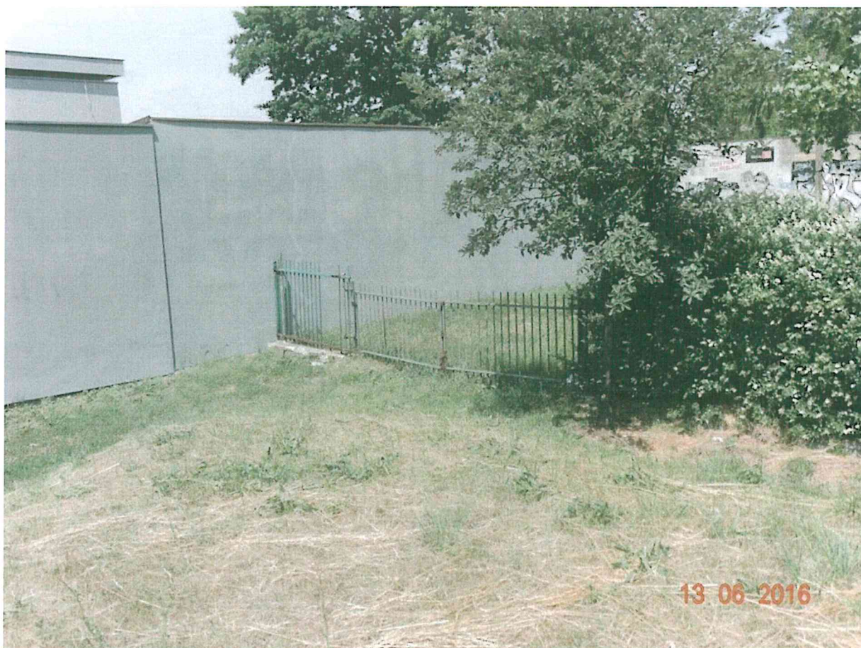
Zdj.5 -Przedstawiające istniejącą bramę od ulicy Kobusiewicza (w załączeniu mapka –brama nr 2). Zakres inwestycji obejmować będzie rozbiórkę istniejącej bramy i postawienie nowej wraz z wykonaniem zjazdu publicznego.
